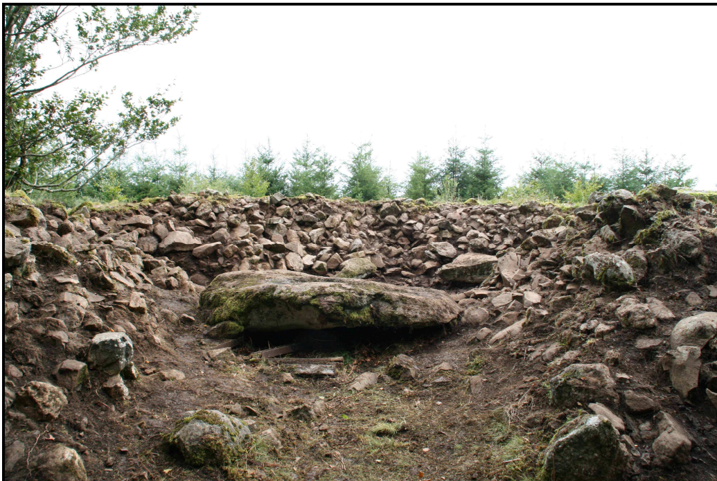
Estado al finalizar los trabajos
