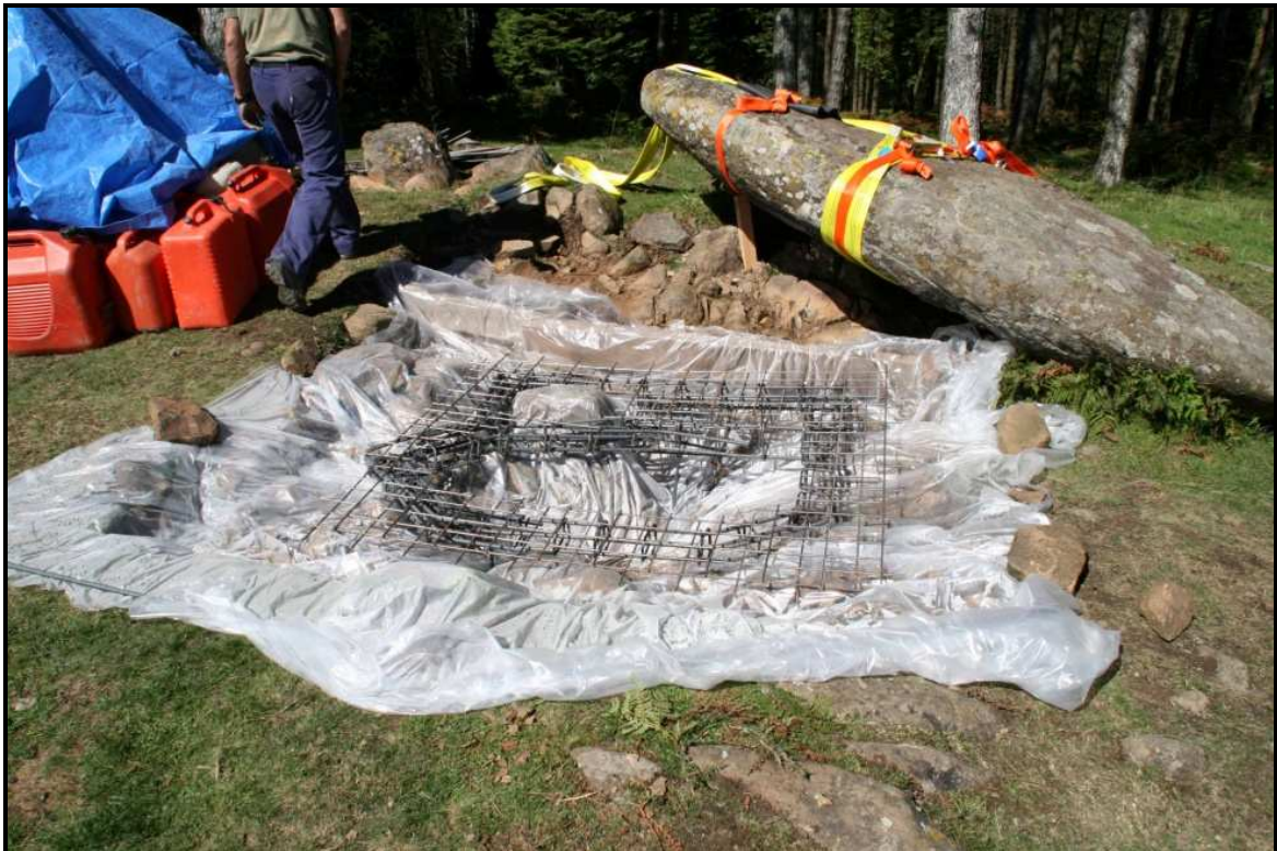
Colocación del plástico y la armadura para alojar el monolito
