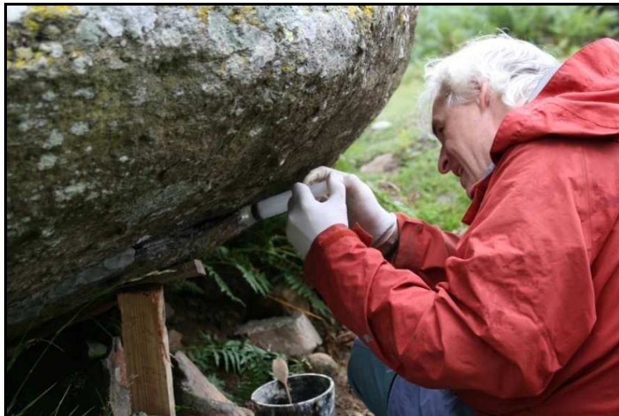
Varios momentos del sellado de las fisuras con resina
