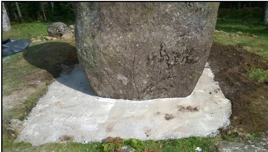
Hormigón ya fraguado
