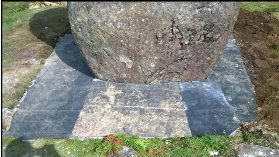
Protección de la cimentación mediante caucho butilo
