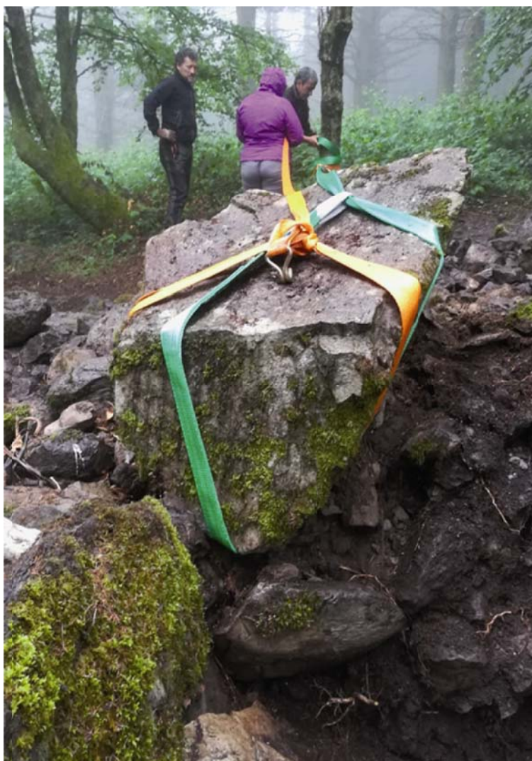
Figura 10. Desplazamiento de la losa UE4.6
