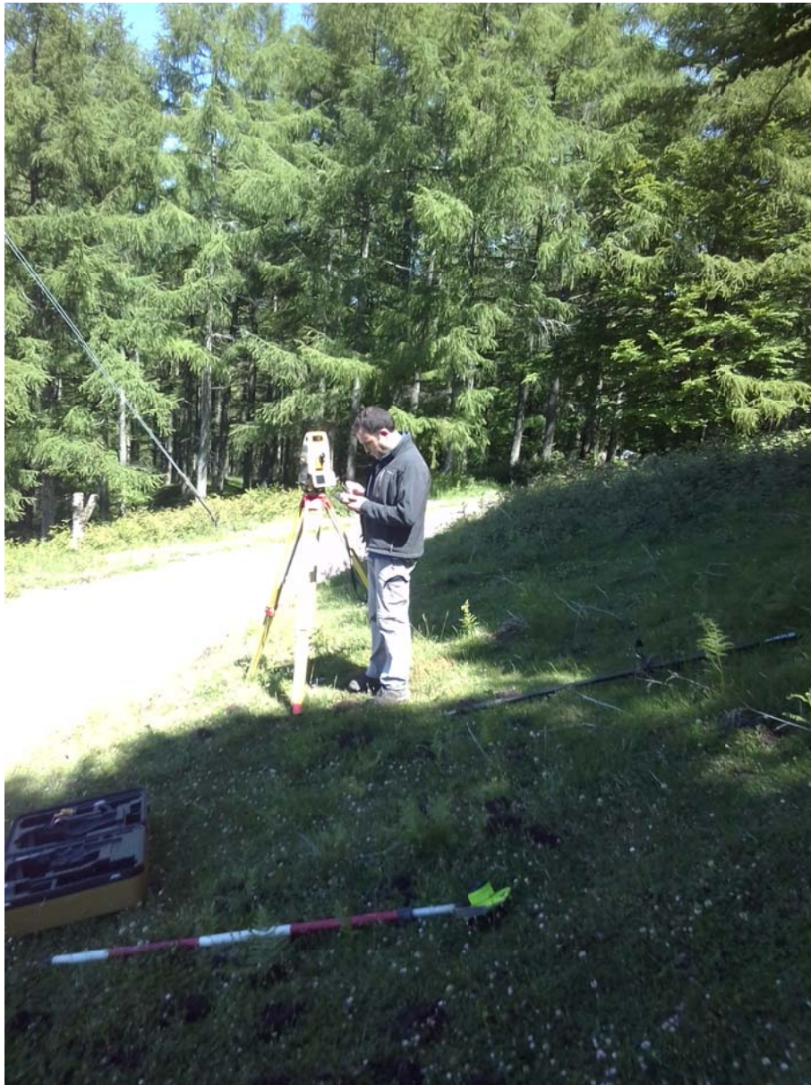
Figura 7. Trabajos de topografía
