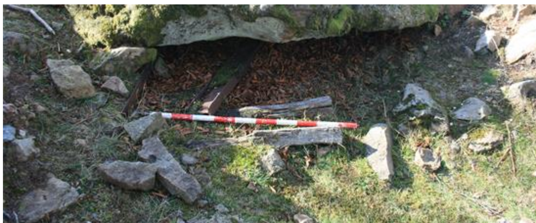
Restos de viguetas metálicas y cabrios de madera bajo la losa de cubrición.
